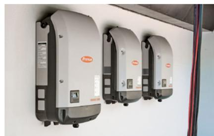
Die drei bereits montierten, aber noch nicht angeschlossenen Fronius Wechselrichter.
