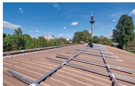
115 Hochleistungsmodulen (Bild links) sind auf dem für das „Tonnendach“ der Tennisanlage zugeschnittenen Montagesystem (Bild rechts) montiert.
